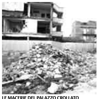
LE MACERIE DEL PALAZZO CROLLATO
