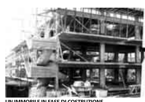
UN IMMOBILE IN FASE DI COSTRUZIONE
