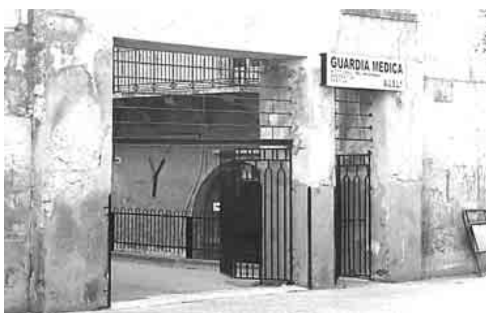
LA GUARDIA MEDICA DI PIAZZA MATTEOTTI RECENTEMENTE CHIUSA DALL'AZIENDA SANITARIA LOCALE N.1
