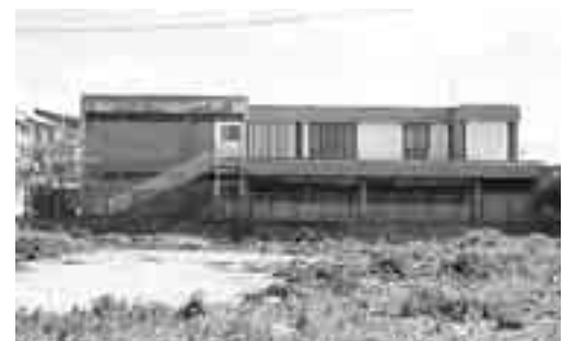
La scuola Giovanni Pascoli attualmente oggetto di alcuni necessari lavori di ristrutturazione
