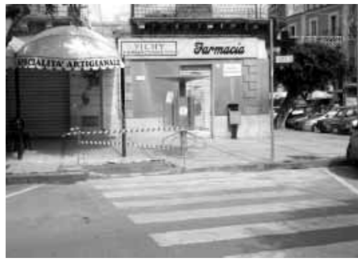
Lo scivolo «incriminato». Il passaggio è ostruito da un palo di sostegno di una pensilina
